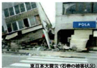
東日本大震災(石巻の被害状況)
